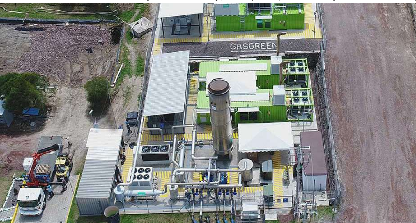
Planta de Biogás – Relleno Sanitario de El Inga, Ecuador. Empresa Metropolitana de Gestión Integral de Residuos Sólidos (EMGIRS-EP)
