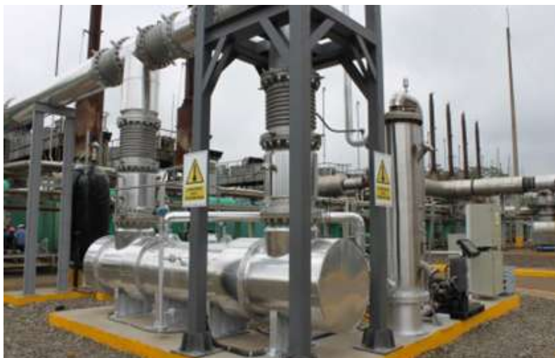
Gráfico 4: Planta Piloto de Ciclo Rankine Orgánico de la Central Termoelectrica de Quevedo
